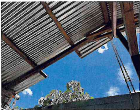
Foto 1: Sustrucción de estructura de soporte por (madera o metal)
