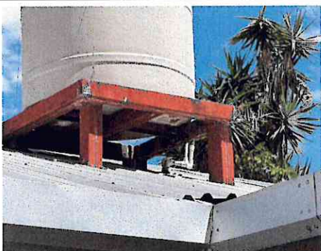
Foto 3: Sustrucción de tinaco de agua potable
