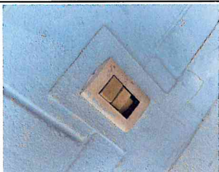
Foto 5: Reparación del sistema eléctrico en aulas
