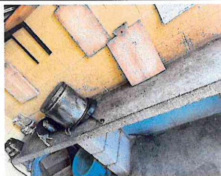
Foto 4: Sustrucción de piso de concreto por piso de cerámico en cocina.
